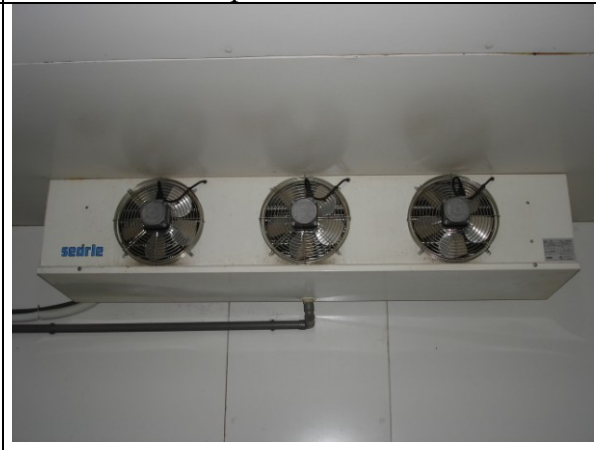
Verdamper in de koelruimte
